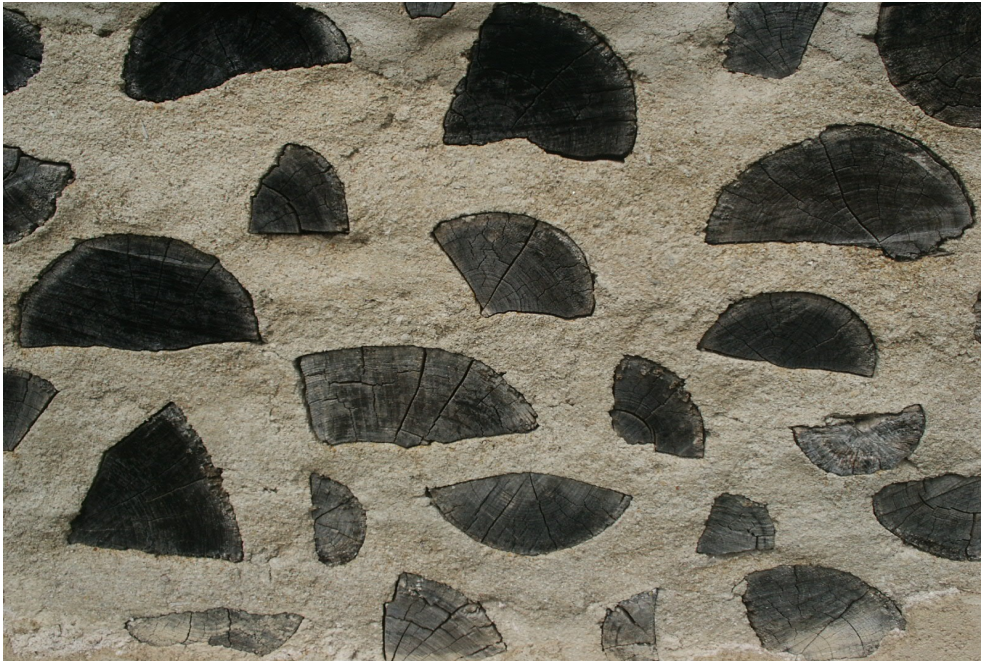
Aspect mur fini (intérieur et extérieur si non enduit)
